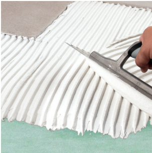
Applicazione del Gel-Adesivo strutturale H40 Revolution .
