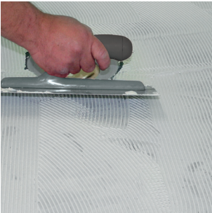
Applicazione del Gel-Adesivo strutturale H40 Revolution .
