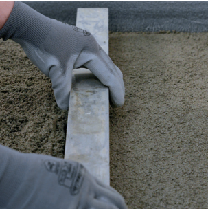
Posa del massetto con Keracem Eco Pronto .
