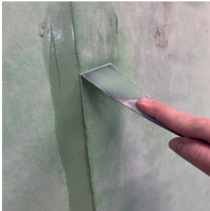
Posa del sigillante organico monocomponente Aquastop Fix .
