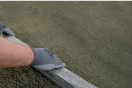
Posa del massetto con Keracem Eco Prontoplus .
