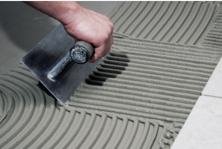
Applicazione del Gel-Adesivo strutturale flessibile multiuso tixo & fluido H40 Revolution .
