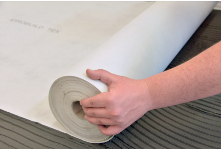
Applicazione della membrana desolidarizzante Biotex .
