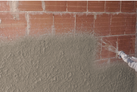
Applicazione della malta tixotropica fibrorinforzata Metric R2 Fix .
