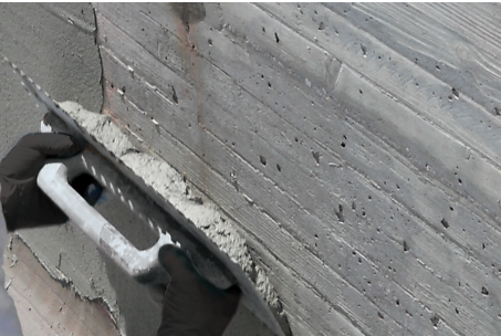
Applicazione di rasante impermeabile minerale Aquastop Scuba .
