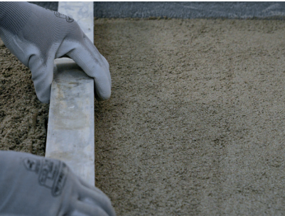
Posa del massetto con Keracem Eco Pronto .
