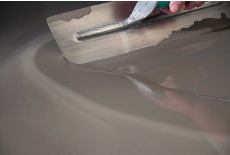
Applicazione del gel autolivellante Planogel Rheo .
