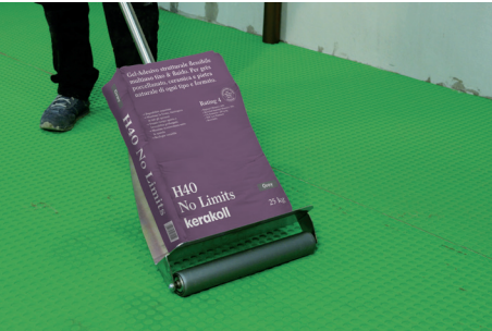
Applicazione della membrana impermeabile antifrattura Aquastop Green .
