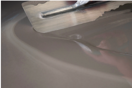
Applicazione del gel autolivellante Planogel Rheo .
