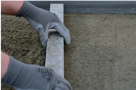
Posa del massetto con Keracem Eco Pronto .
