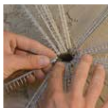
Τοποθέτηση του αγκυρίου Geosteel εντός της οπής
