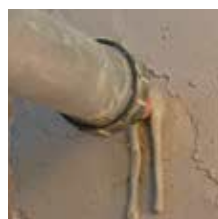
Πλήρωση του αγκυρίου τύπου θυσάνου με ενεμάτωση του Geocalce FL Antisismico
