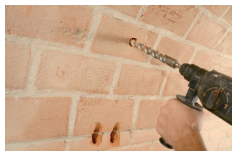
Esecuzione dei fori pilota.
