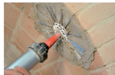
Inghisaggio dei diatoni con Geocalce FL Antisismico .
