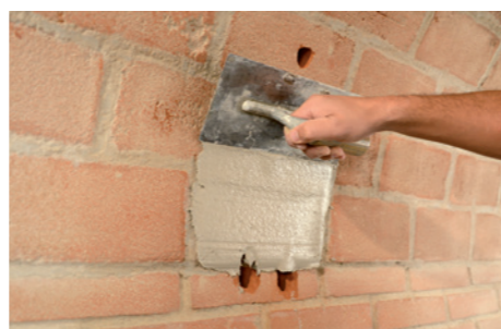
Applicazione prima mano di Geocalce F Antisismico .
