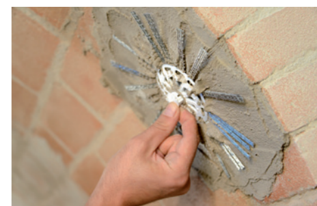
Chiusura del foro di iniezione con apposito tappo di chiusura.
