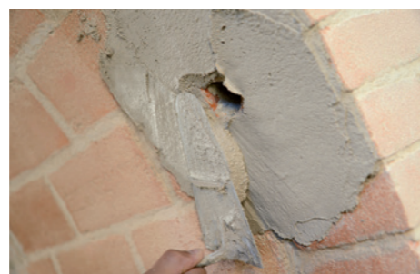
Applicazione prima mano di Geocalce F Antisismico .
