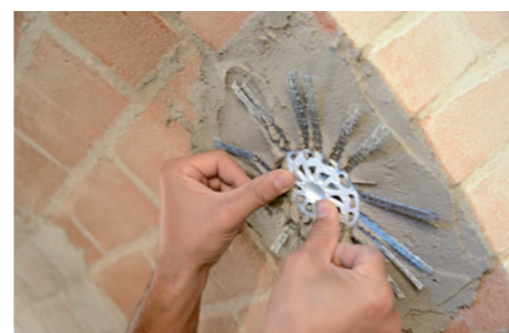
Installazione di Iniettore&Connettore Geosteel .
