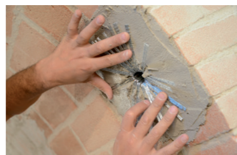
Installazione del Diatono Geosteel .
