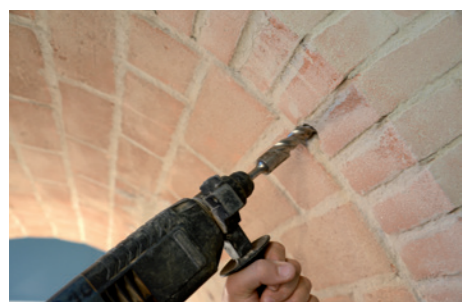
Realizzazione dei fori pilota.
