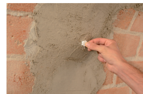
Inghisaggio degli ancoraggi e dei connettori con Geocalce FL Antisismico e chiusura del foro di iniezione con apposito tappo di chiusura.
