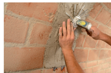
Installazione del Diatono Geosteel .
