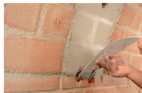
Installazione del tessuto in fibra d'acciaio Geosteel .
