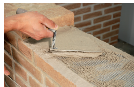
2 Stesura del secondo strato di Geocalce F Antisismico .
