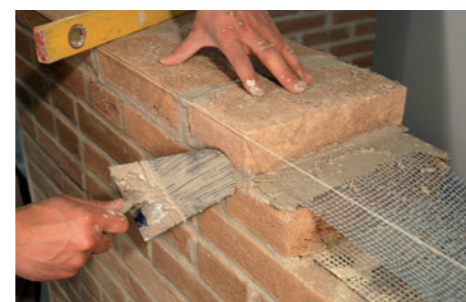
3 Posa dei ricorsi in laterizio.
