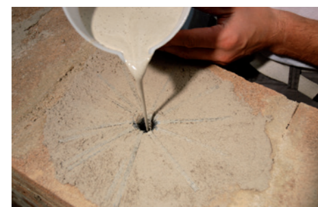
6 Inghisaggio del connettore con Geocalce FL Antisismico .
