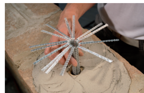
5 Inserimento del Diatono Geosteel .
