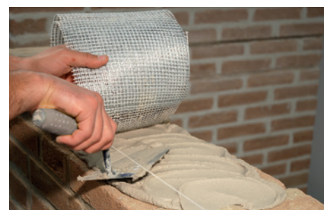
1 Stesura del primo strato di Geocalce F Antisismico e posa del tessuto Geosteel G .
