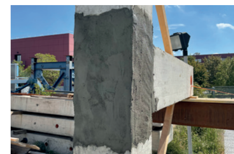
Ripristino del copriferro con Geolite 40 .
