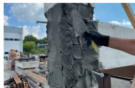
Primo strato di malta Geolite 40 .
