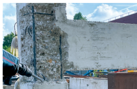
Preparazione del supporto.
