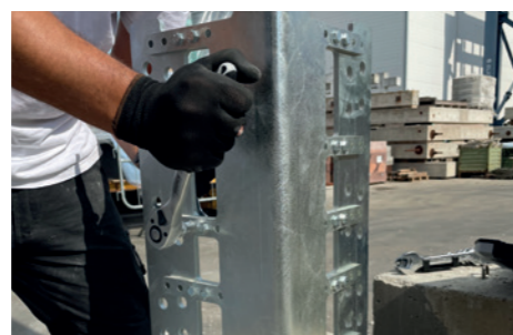
Assemblaggio dei moduli Steel Combo .
