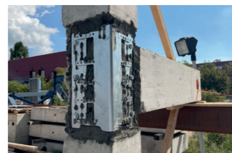
Installazione sistema Steel Combo .
