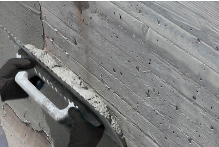
Applicazione di rasante impermeabile minerale Aquastop Scuba .
