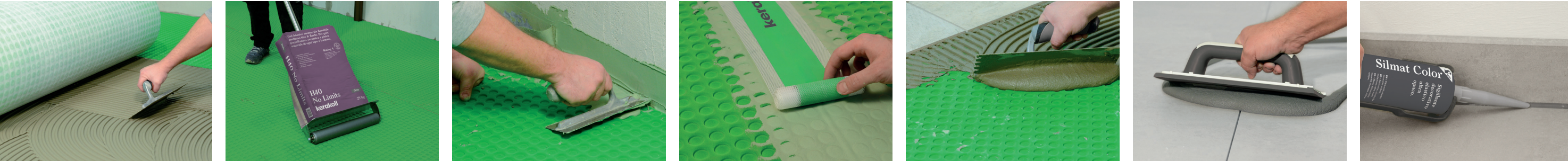
Applicazione del Gel-Adesivo strutturale flessibile multiuso H40 No Limits . Posa della membrana impermeabile antifrattura Aquastop Green . Applicazione sigillante organico monocomponente Aquastop Fix . Posa del nastro impermeabile elastico in NBR Aquastop 120 . Applicazione del Gel-Adesivo strutturale flessibile multiuso H40 No Limits . Posa della resina-cemento decorativa per stuccatura Fugabella Color . Applicazione del sigillante decorativo per piastrelle Silmat Color .
