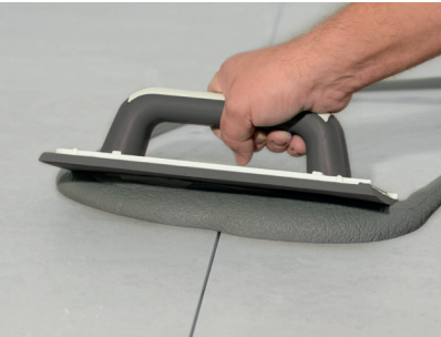
Posa della resina-cemento decorativa per stuccatura Fugabella Color .
