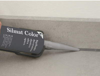
Applicazione del sigillante decorativo per piastrelle Silmat Color .
