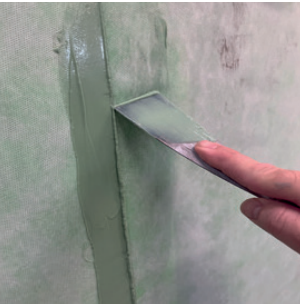
Posa del sigillante organico monocomponente Aquastop Fix .
