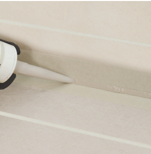
Applicazione del sigillante decorativo per piastrelle Silmat Color .
