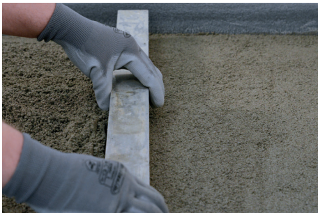
Posa del massetto con Keracem Eco Pronto .
