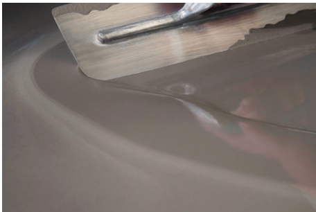
Applicazione del gel autolivellante Planogel Rheo .
