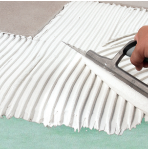
Applicazione del Gel-Adesivo strutturale H40 Revolution .
