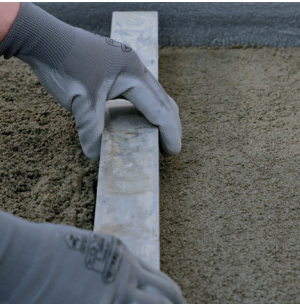
Posa del massetto con Keracem Eco Pronto .
