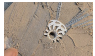
Stuccatura finale del connettore dopo l'inserimento del tassello in polipropilene
