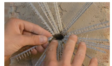
Installazione del connettore
