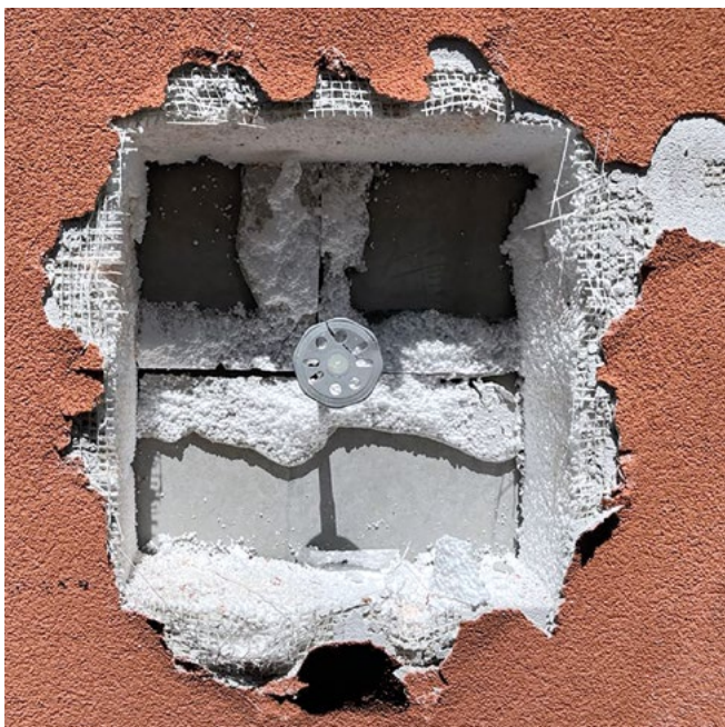
Finestra di valutazione sistema ETICS esistente
