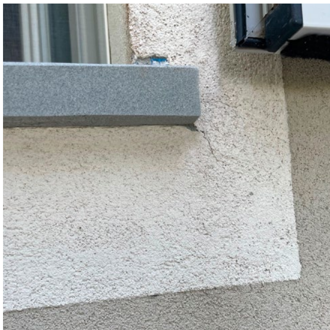
Cavillatura in prossimità del davanzale
