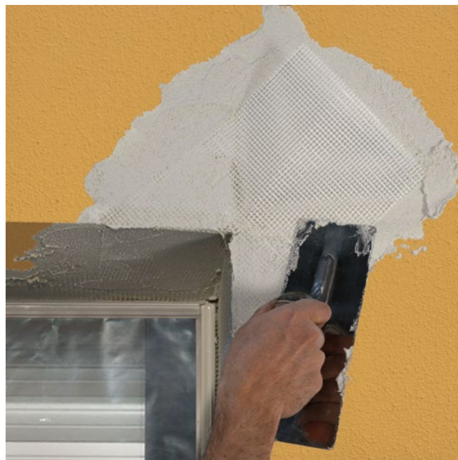
Applicazione fazzoletto di rete di rinforzo
