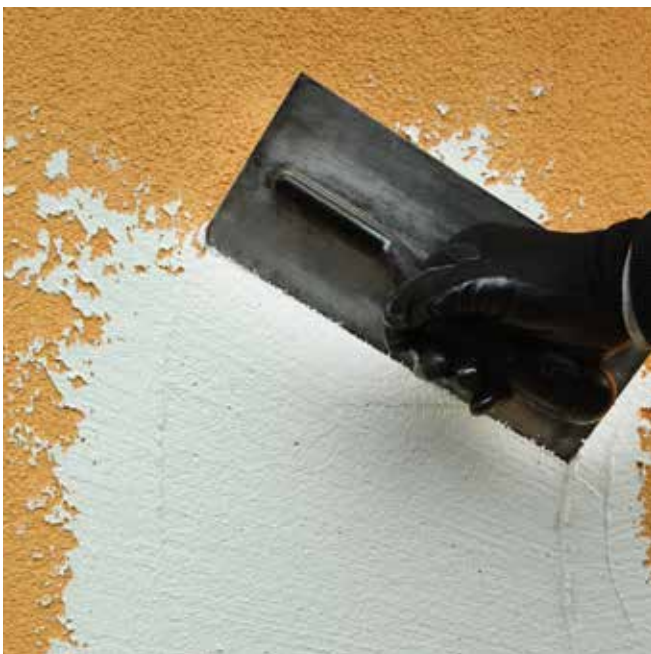
Εφαρμογή στρώσης ενίσχυσης
