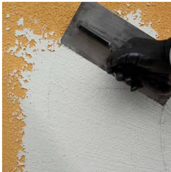
Επιδιόρθωση, σύμφωνα με τις προδιαγραφές, των τμημάτων που απομακρύνθηκαν
