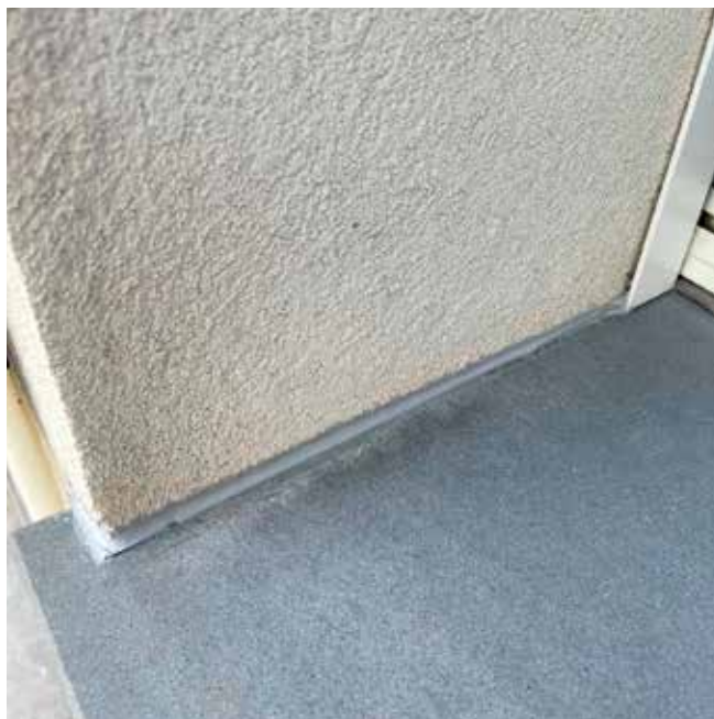
Εφαρμογή κατάλληλου σφραγιστικού σε επαφή με άκαμπτο στοιχείο
