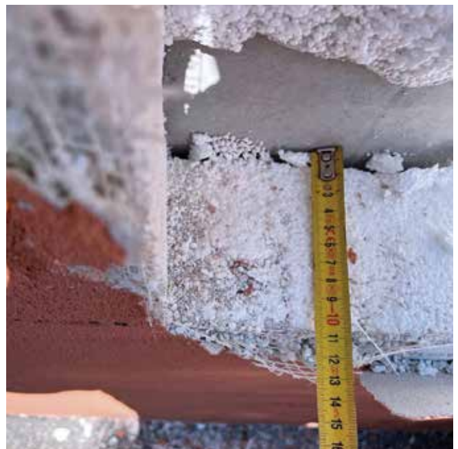
Έλεγχος πραγματικής κατάστασης υφιστάμενου συστήματος ETICS
