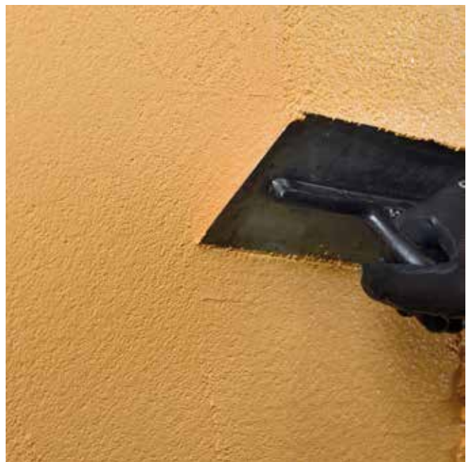
Εφαρμογή τελικού επιχρίσματος (αστάρι και πάστα)
