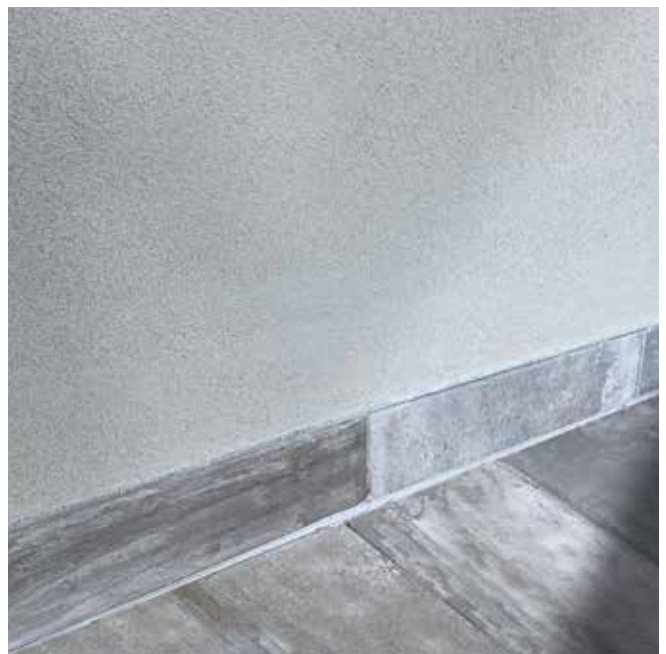
Αποκατάσταση συστήματος ETICS σε επαφή με το έδαφος
