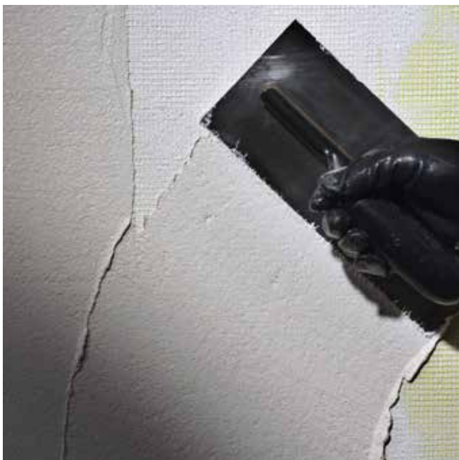
Εφαρμογή στρώσης ενίσχυσης
