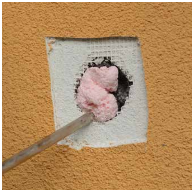
Εφαρμογή κατάλληλου αφρού πολυουρεθάνης για πλήρωση
