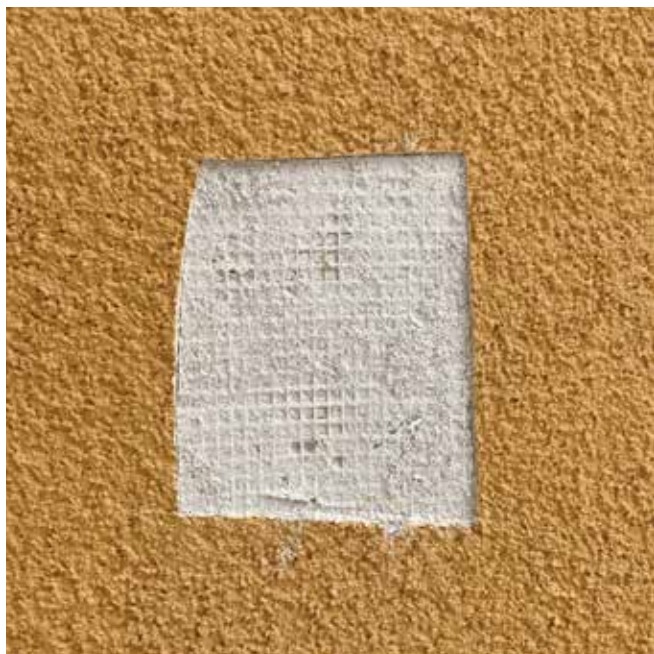
Τοπική αφαίρεση τελικού επιχρίσματος & δεύτερου χεριού στρώσης ενίσχυσης
