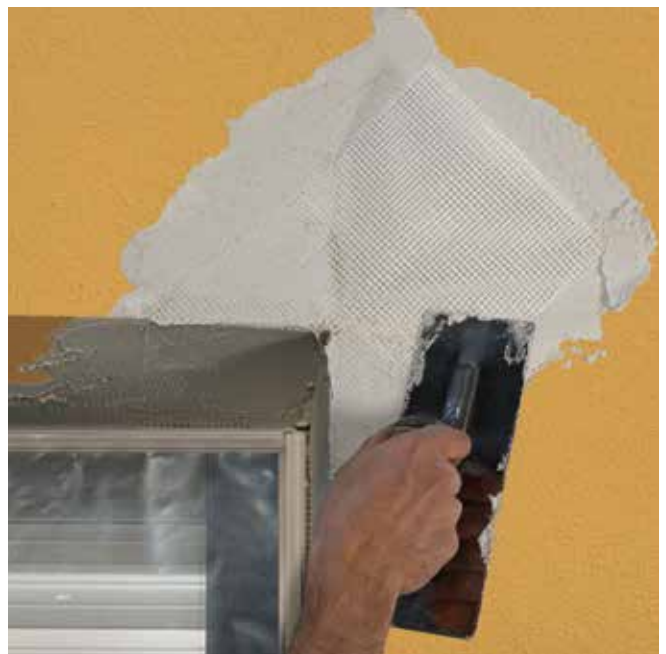
Εφαρμογή γωνιακού πλέγματος κουφωμάτων
