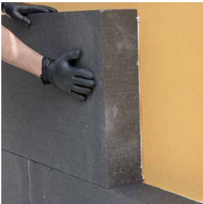
Επικόλληση θερμομονωτικού πάνελ
