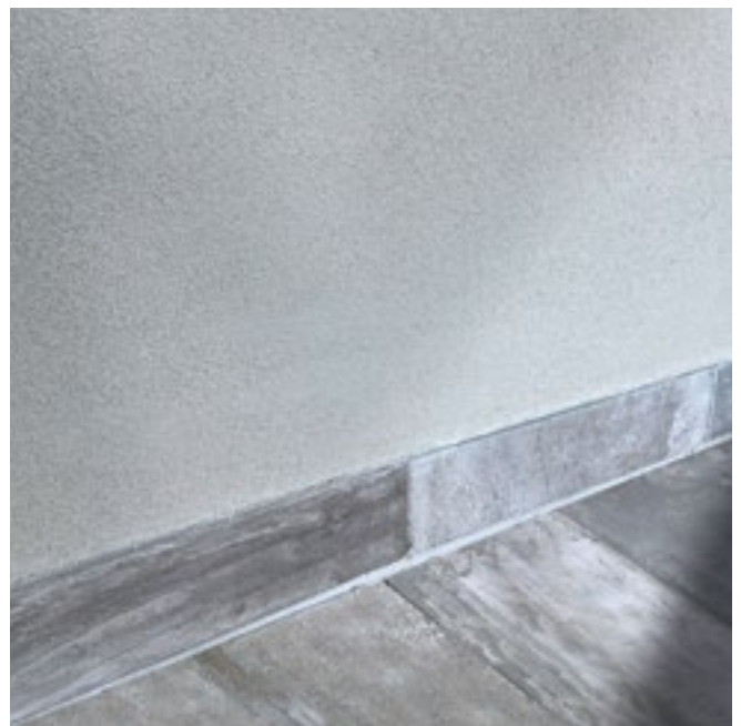
Ripristino sistema ETICS a contatto con il terreno
