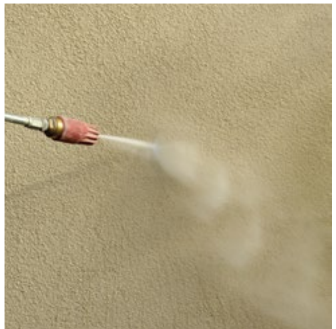
Idrolavaggio della superficie
