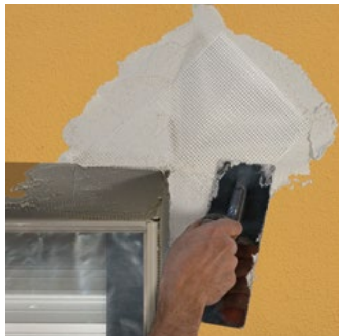
Applicazione fazzoletto di rete di rinforzo
