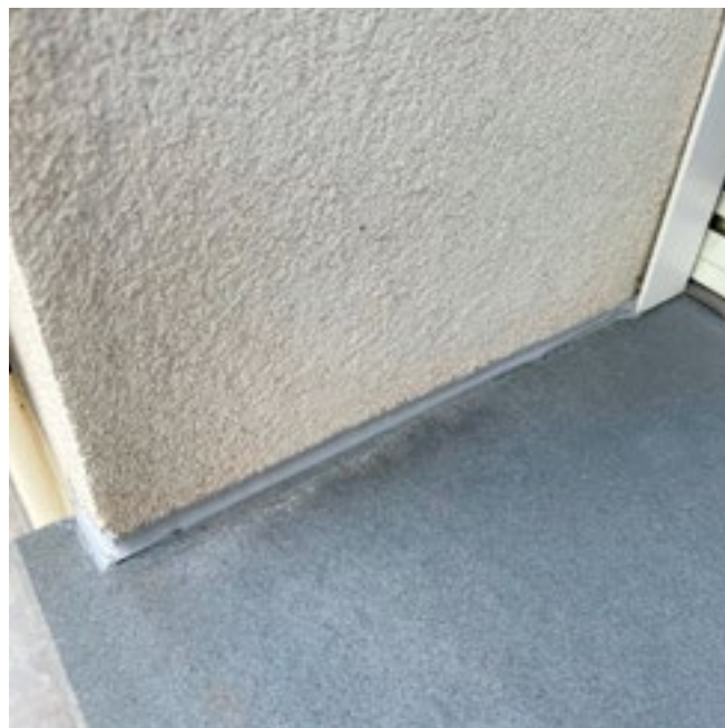
Applicazione idoneo sigillante a contatto con elemento rigido
