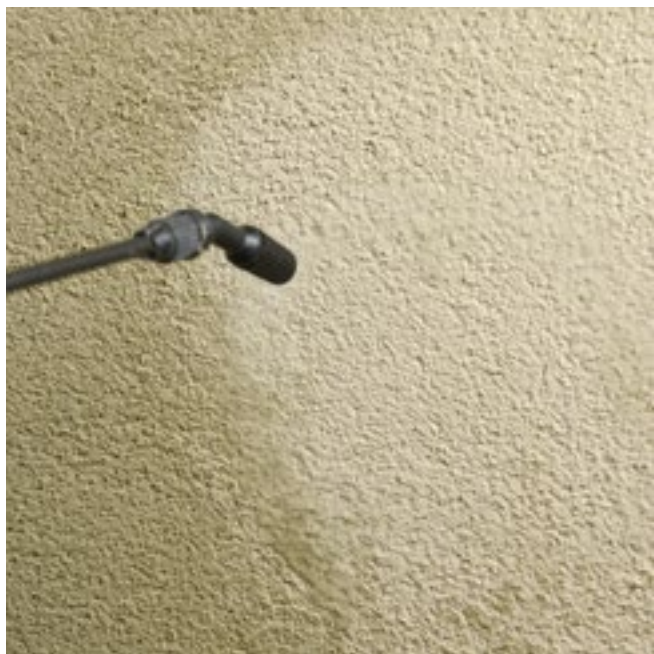
Traitement avec un produit d'assainissement approprié
