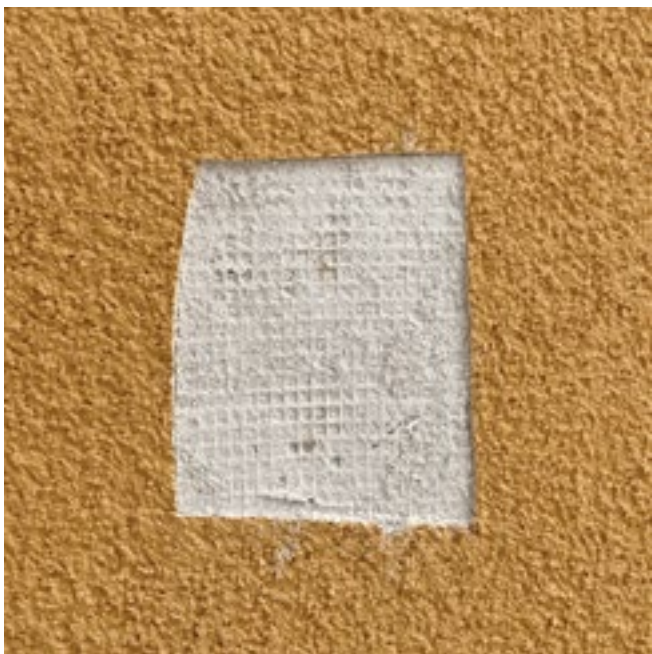
Enlèvement localisé du cycle de finition et de la deuxième couche de ragréage
