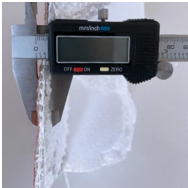
Contrôle de la qualité du système ETICS existant
