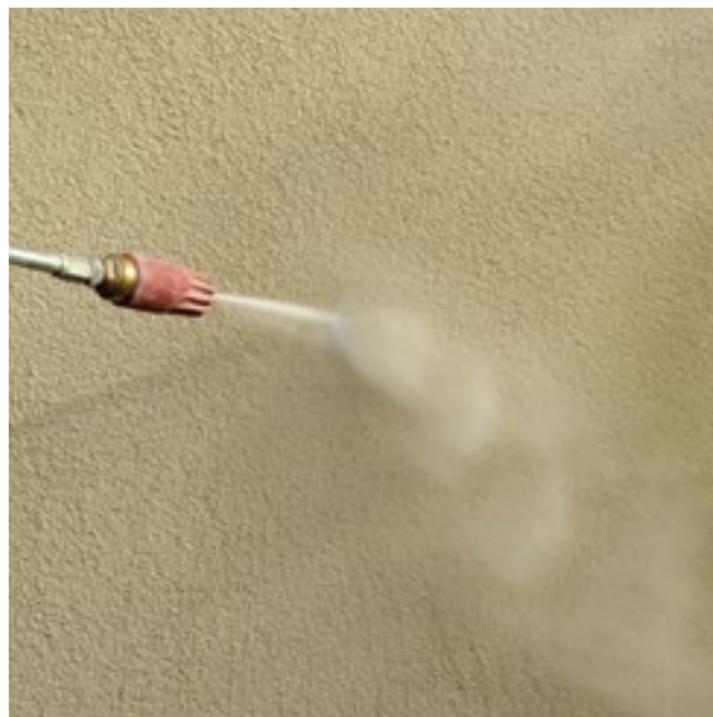
Lavage sous pression de la surface
