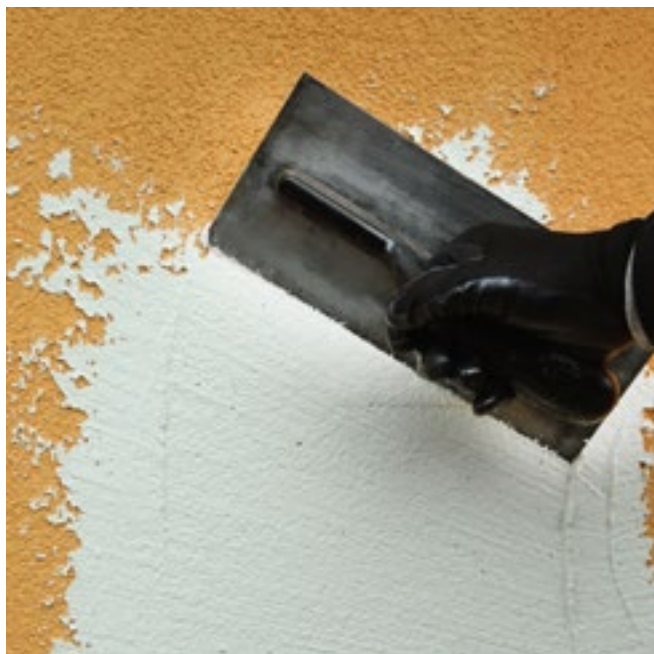
Application du sous-enduit armé
