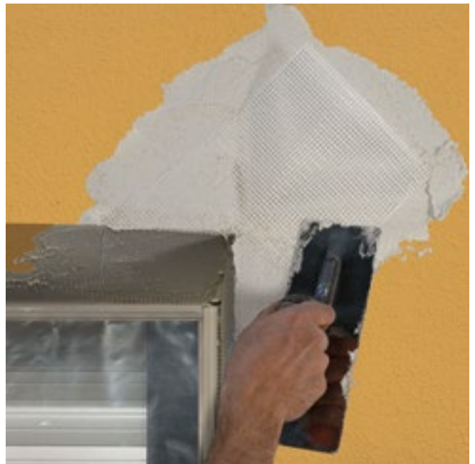
Application d'un morceau de treillis de renforcement
