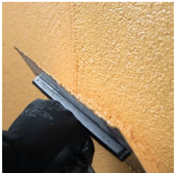
Application du cycle de finition (couche de finition et crépi en épaisseur)
