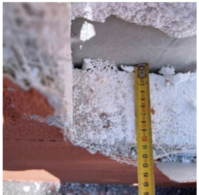
Vérification de l'état de fait du système ETICS existant
