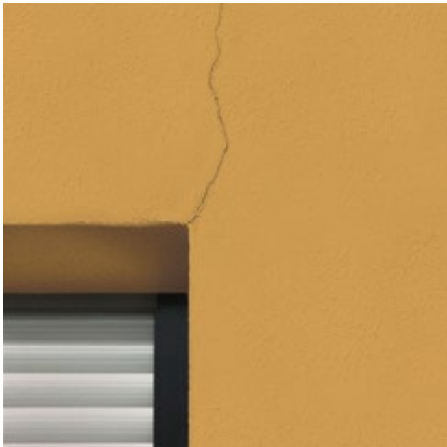
Craquelure dans l'angle de l'ouverture
