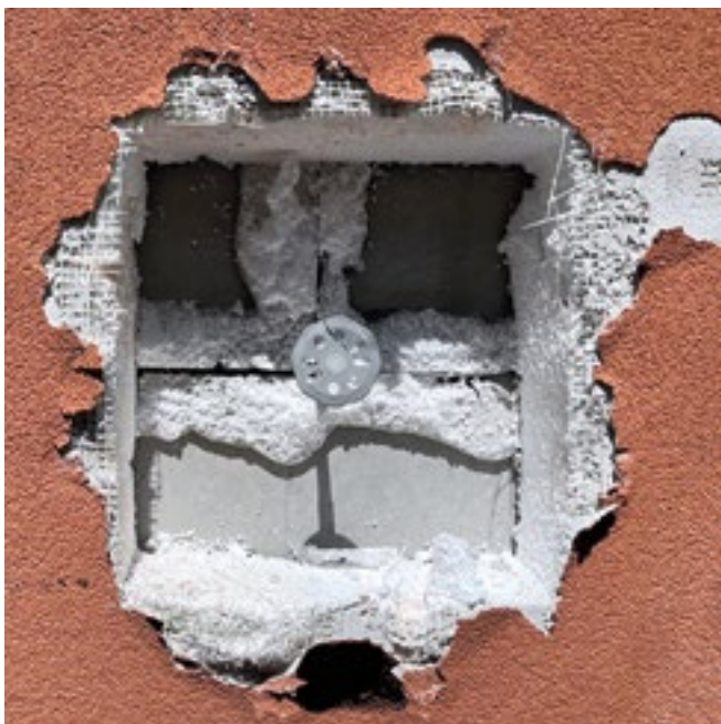
Inspection visuelle du système ETICS existant
