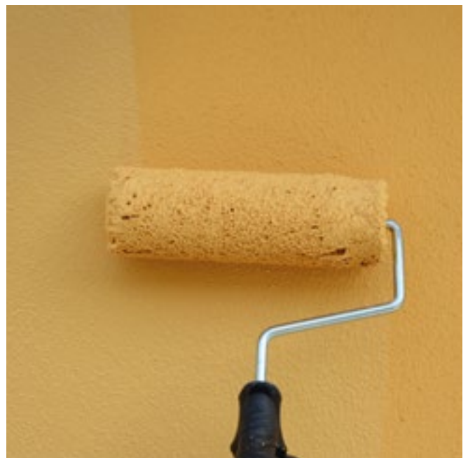
Application du cycle de décoration en deux couches
