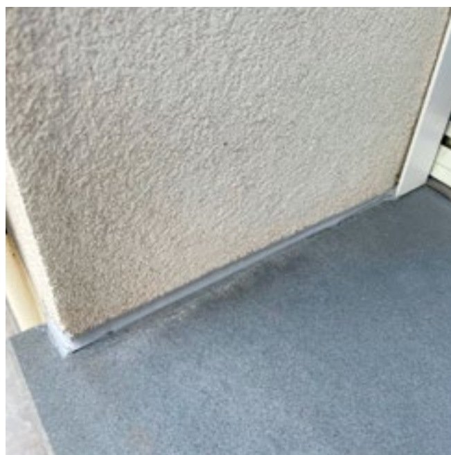
Application d'un mastic d'étanchéité approprié en contact avec un élément rigide
