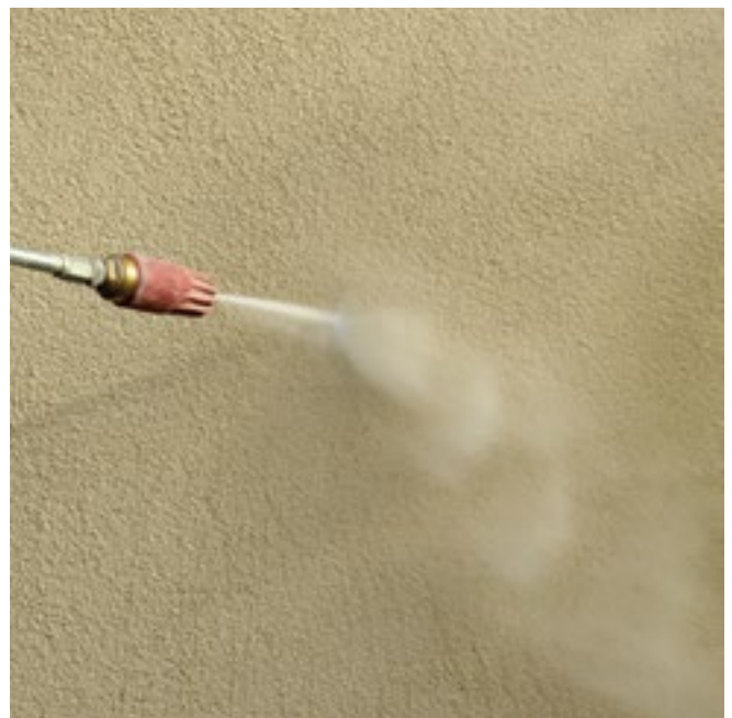
Hochdruck-Wasserstrahl der Oberfläche
