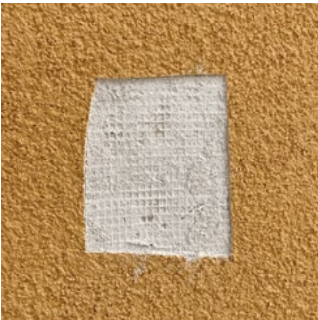
Lokal begrenzte Entfernung der Oberflächenbeschichtung und der zweiten Glattschicht
