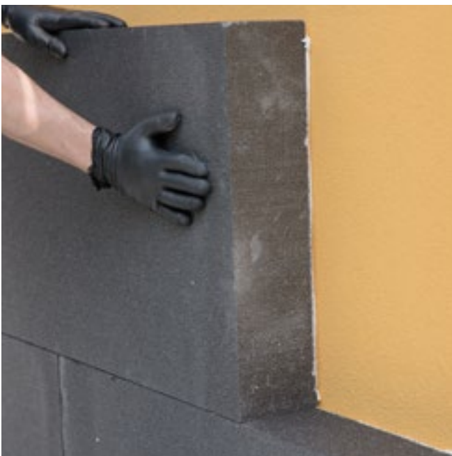
Verkleben der Platten
