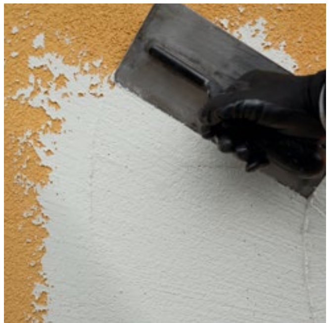
Ausbessern der vom Abtrag betroffenen Bereiche
