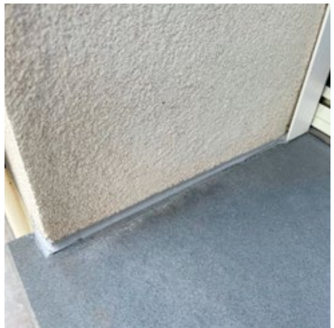
Auftragen eines geeigneten Dichtmittels im Kontaktbereich mit dem starren Bauteil
