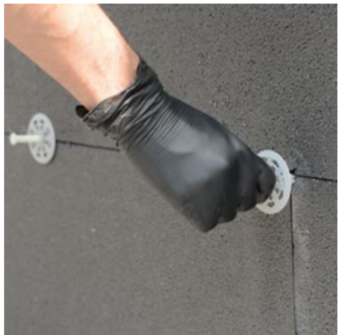
Verdübelung der Platten
