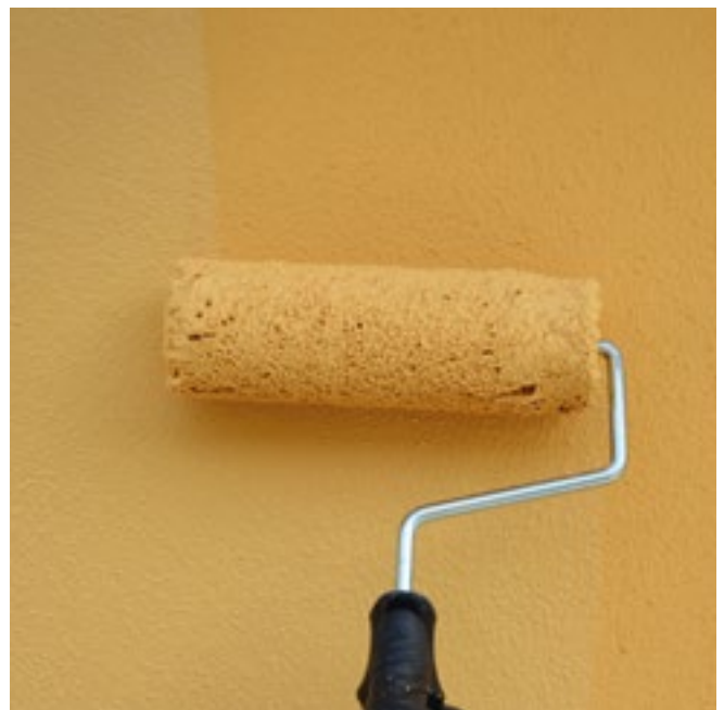
Auftragen der Dekorationsschicht in zwei Arbeitsgängen
