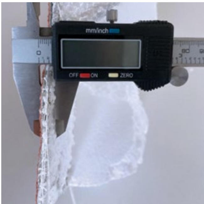
Überprüfung der Qualität des bestehenden ETICS/WDVS
