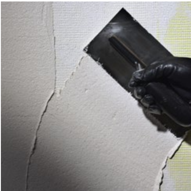
Auftragen der armierten Glättschicht
