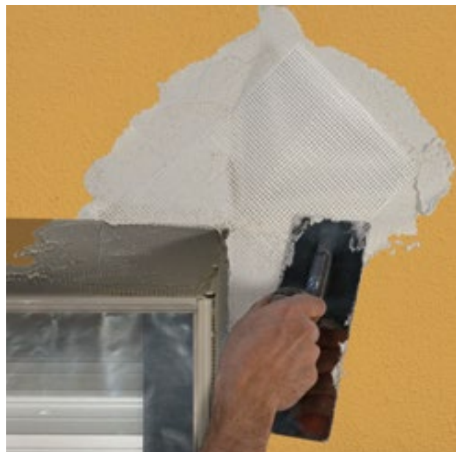
Anbringen eines Verstärkungsnetzstücks
