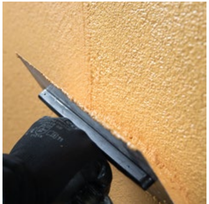
Auftragen der Oberflächenbeschichtung (Grundierung und dickschichtig aufgetragener Edelputz)
