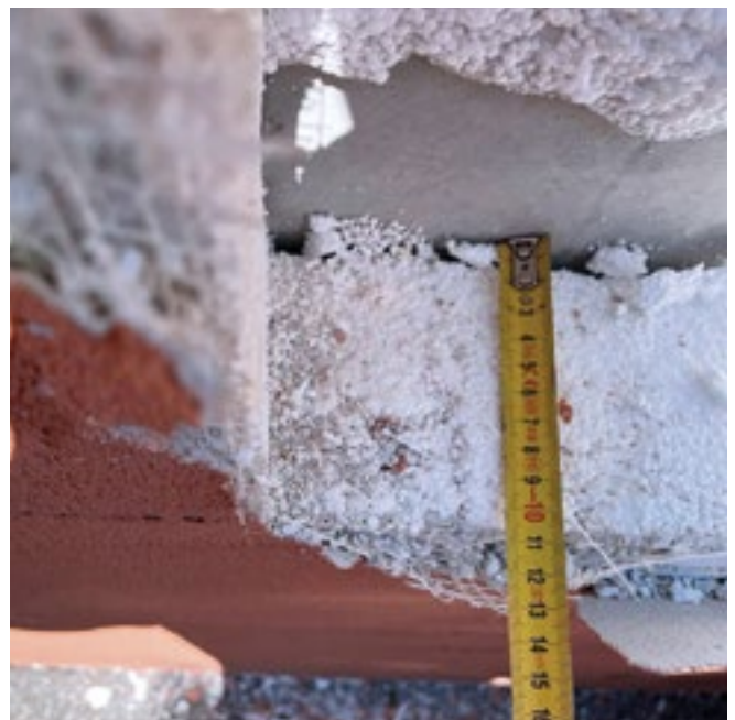
Überprüfung Ist-Zustand des bestehenden ETICS/WDVS
